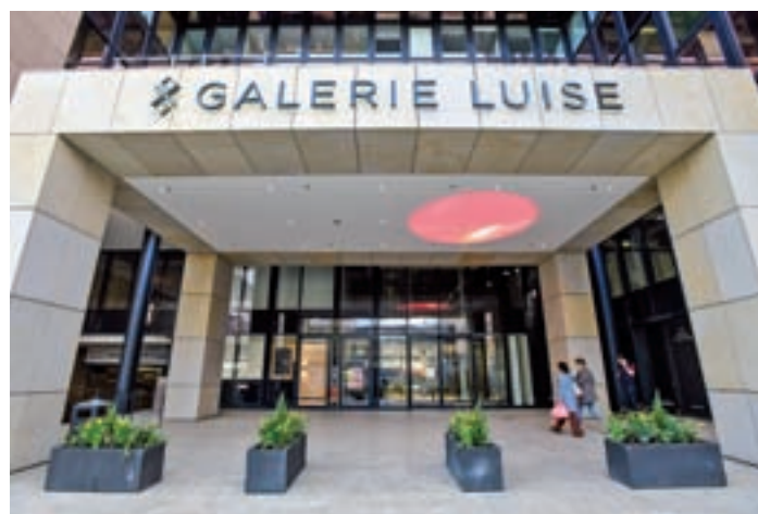
Blick von der Luisenstraße: der neu gestaltete Eingang zur revitalisierten Galerie Luise
