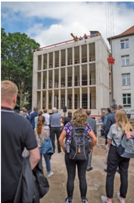
Am 5. Juni wurde Richtfest gefeiert
